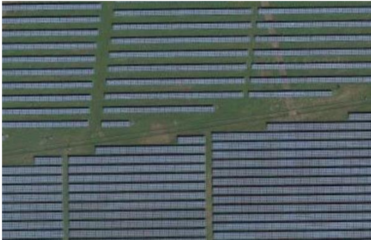
Abb. 25: Unterschiedlicher Reihenabstand in zwei Solarparks auf dem ehemaligen Flugplatz Fürstenwalde
